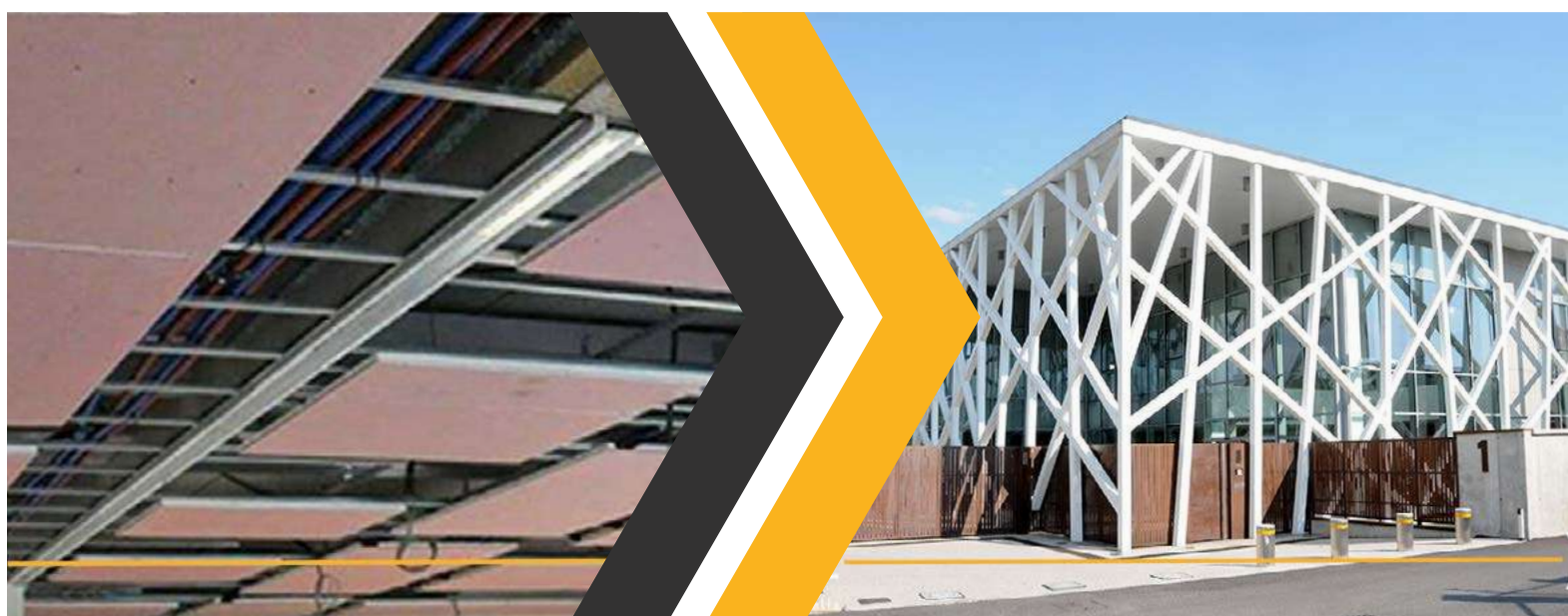
Uffici per edificio di produzione industriale | Brescia - Impianto radiante a soffitto in cartongesso
